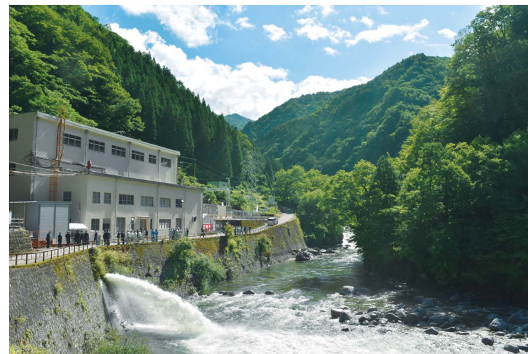
神岡鉱業株式会社 金木戸発電所
